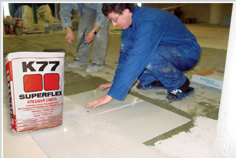
Укладка керамогранита на клей SUPERFLEX K77, Аэропорт Внуково.
