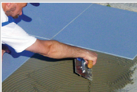
Укладка крупноформатной плитки на клей SUPERFLEX K77
