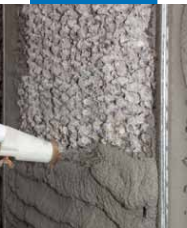
Нанесение MapegROUT 430 набрызгом
