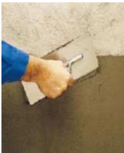
нанесение шпателем
