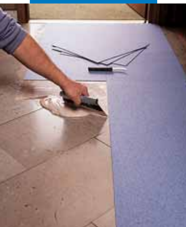
Укладка ПВХ покрытий на непитывающее основание с помощью клея Adesilex G19
