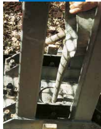
Анкерное крепление с помощью раствора Mapefill
