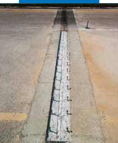
Ремонт шва на автодорожном мосту с использованием раствора Mapefill
