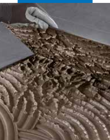
Контроль покрытия тыльной стороны плит из тонкого керамогранита
