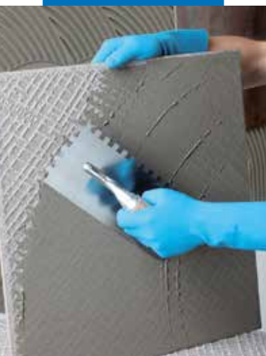
Нанесение Ultralite S1 на тыльную сторону плит
