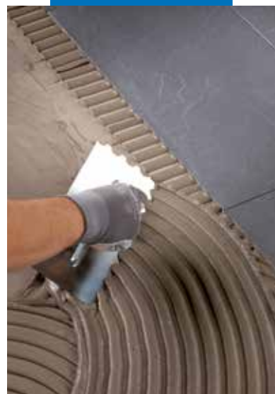
Нанесение клея на пол шпателем с круглыми зубцами размером 9 мм
