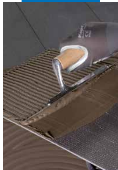
Нанесение клея на тыльную сторону плит
