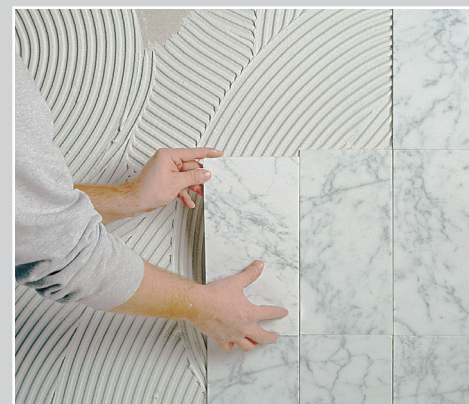
Укладка светлого мрамора на клей LITOSTONE K99
