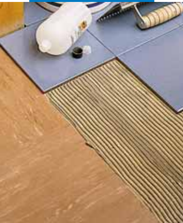
Укладка нового покрытия поверх существующего из ПВХ
